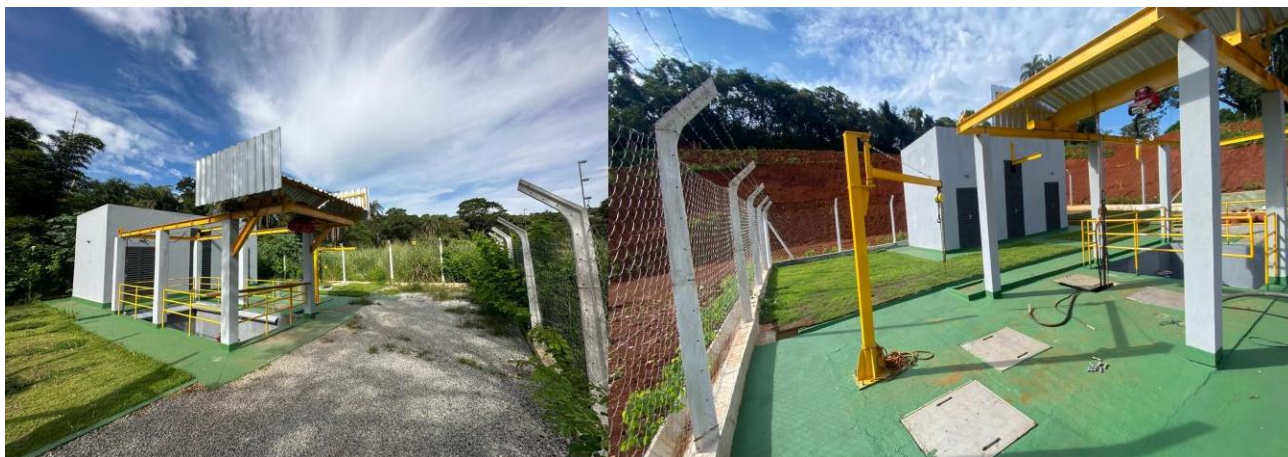
Imagem 06: Construção das elevatórias da futura Estação de Tratamento de Esgoto (ETE) de Itatiaiuçu/MG.
