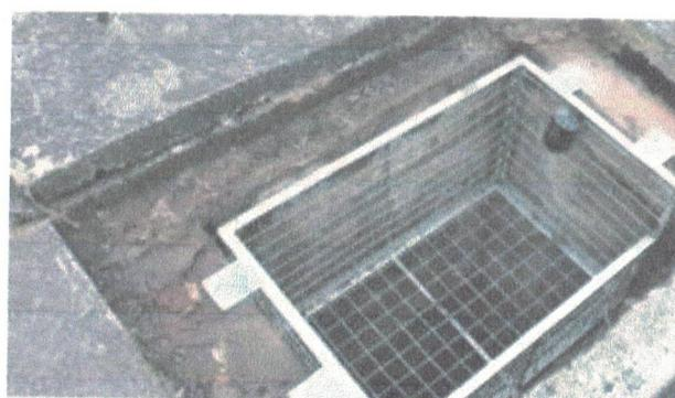
Os bueiros inteligentes são uma solução inovadora e sustentável que ajuda a evitar alagamentos e entupimentos causados pelo acúmulo de lixo e detritos nas vias públicas. Esse sistema conta com dispositivos que retêm resíduos sólidos, facilitando a limpeza e reduzindo custos com manutenção. Além disso, contribui para a preservação ambiental e melhora a eficiência do sistema de drenagem urbana.
